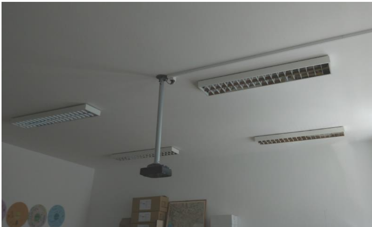
Slika 1: Obstoječe svetilke v učilnicah
